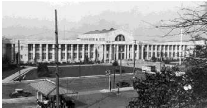
الشكل (7) صورة لمدرسة Oakland Technical High School في ثلاثينيات القرن العشرين،
